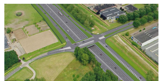
Aanleg ongelijkvloerse kruising Hogering-Hollandsedreef/Pampusdreef
