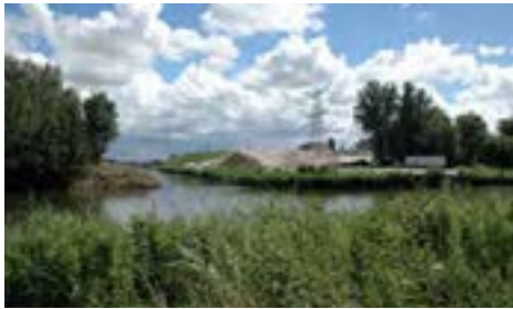
4. Aansluiting via nieuw viaduct A6
