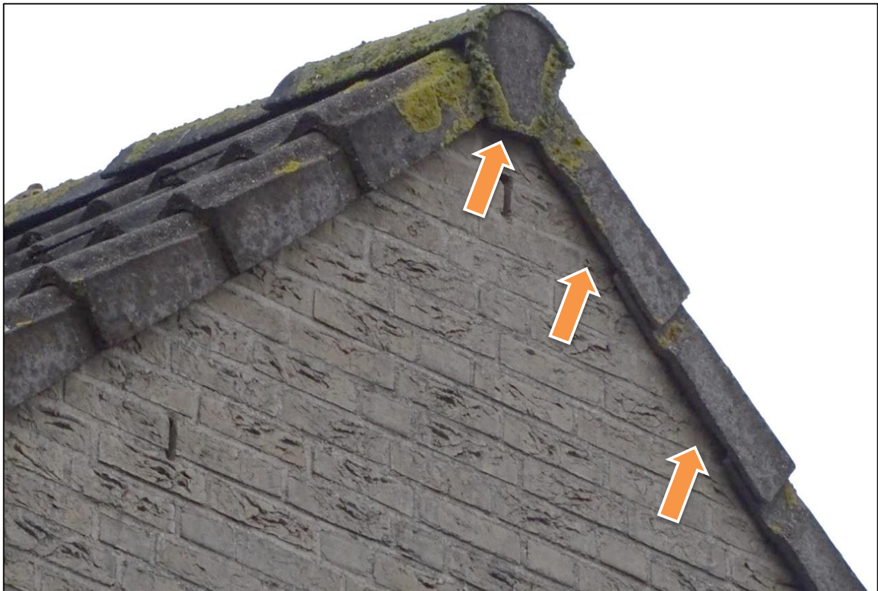
Figuur 4.4 Ruimte onder de kantpannen en eindvorst zijn voldoende voor gierzwaluw om in te kunnen vliegen.
