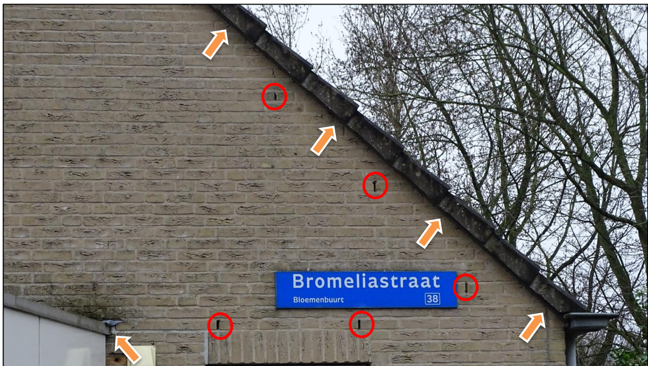
Figuur 4.6 Open stootvoegen, ruimte onder kantpannen, daktrim en losse loodslab bieden geschikte toegang voor vleermuizen.
