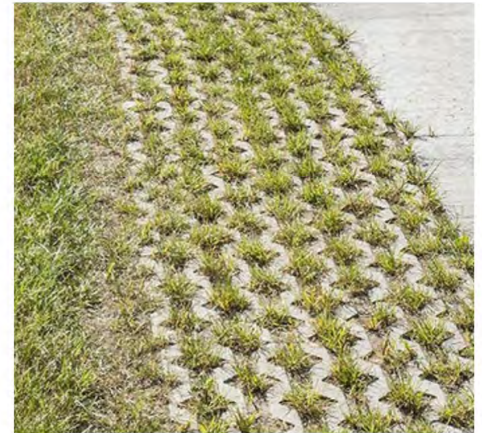
Referentie grasbetontegels laten water door en zorgen voor een minder stenig beeld.
