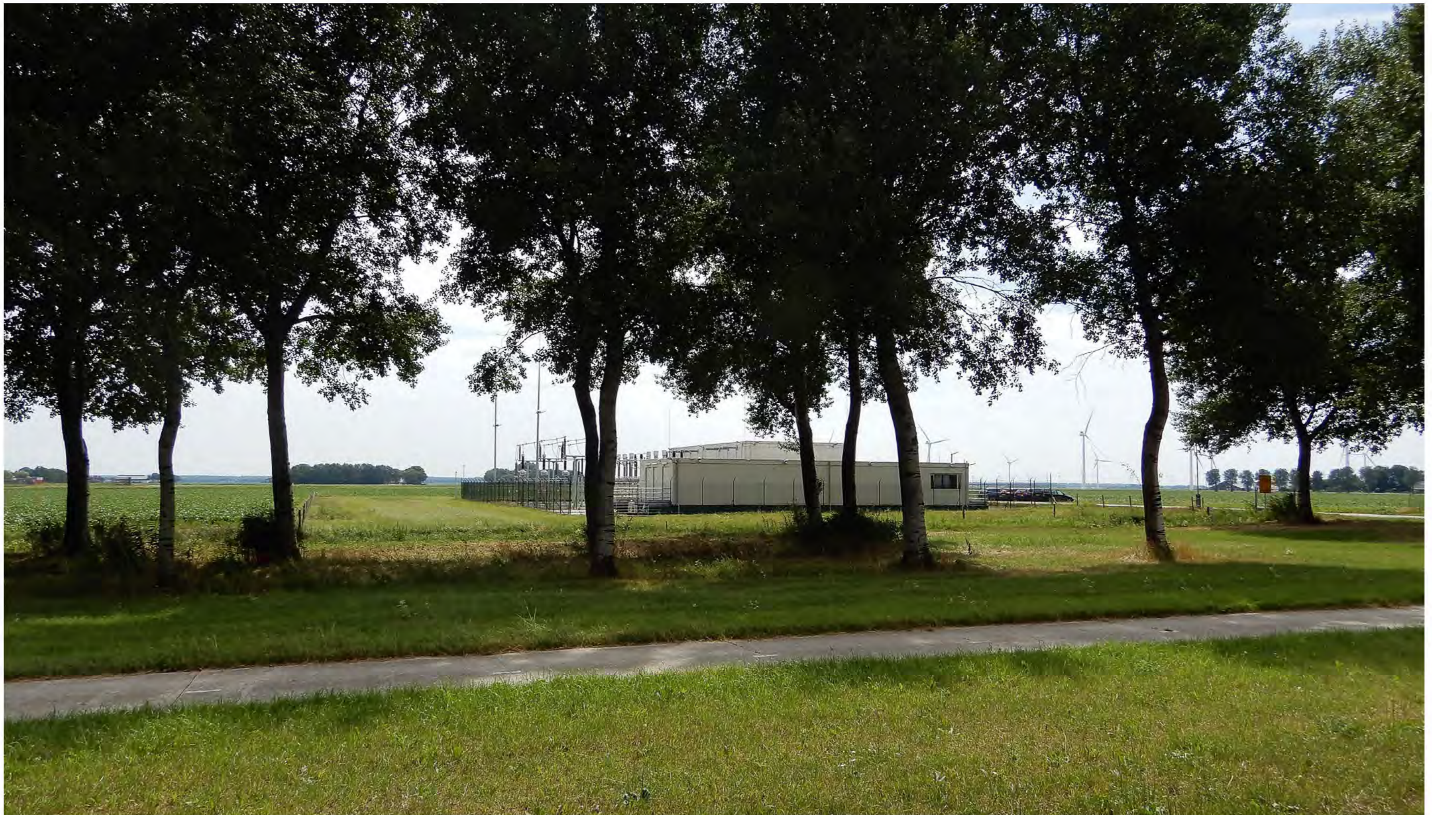
Huidige situatie onderstation aan de Vogelweg, kijkrichting zuidoost: grasberm met bomen langs Vogelweg, bestaande bouwwerken en hek, op de achtergrond agrarische erven met windsingels.
