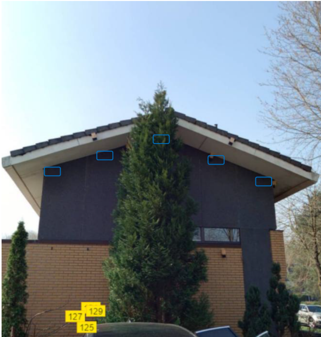
Figuur 12 Locaties van de permanente nestkasten huismus ter plaatse van de kopgevel van Eeuwenweg 125. Bron: http://streetsmart.cyclomedia.nl .
