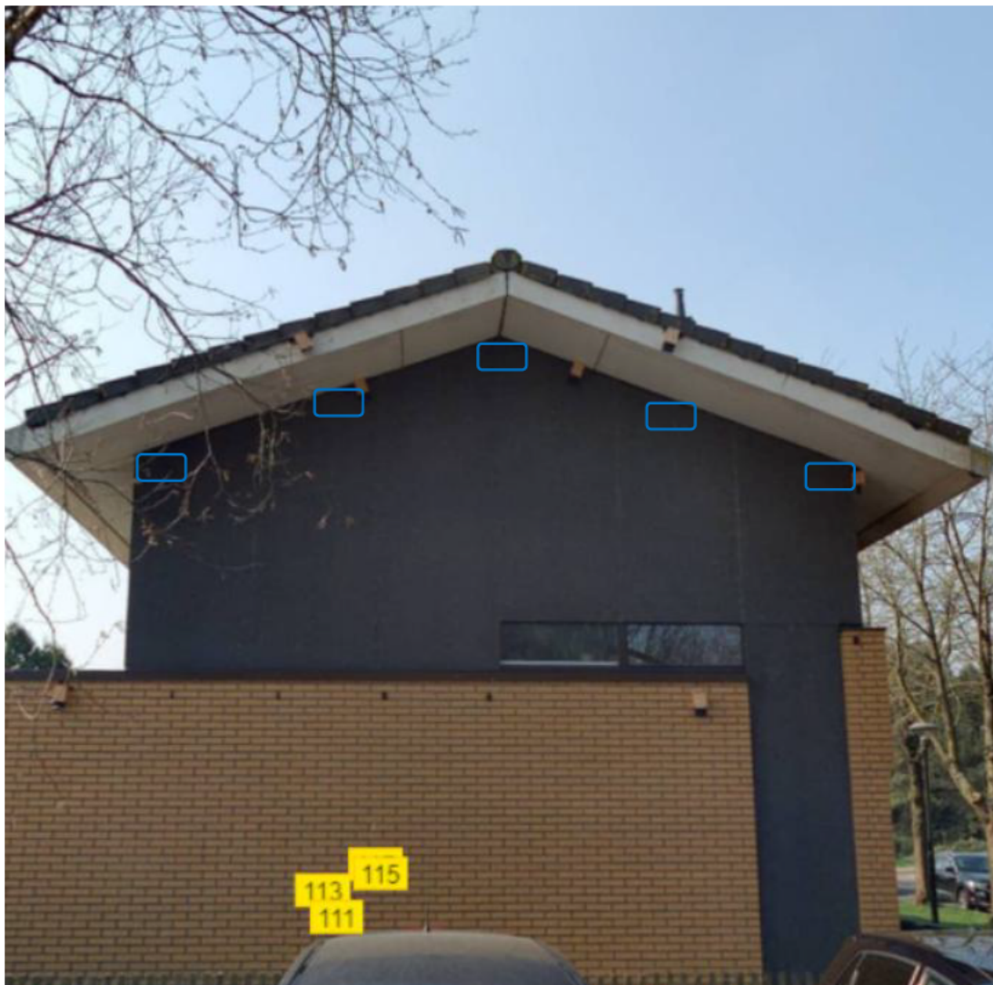
Figuur 11 Locaties van de permanente nestkasten huismus ter plaatse van de kopgevel van Eeuwenweg 111. Bron: http://streetsmart.cyclomedia.nl .
