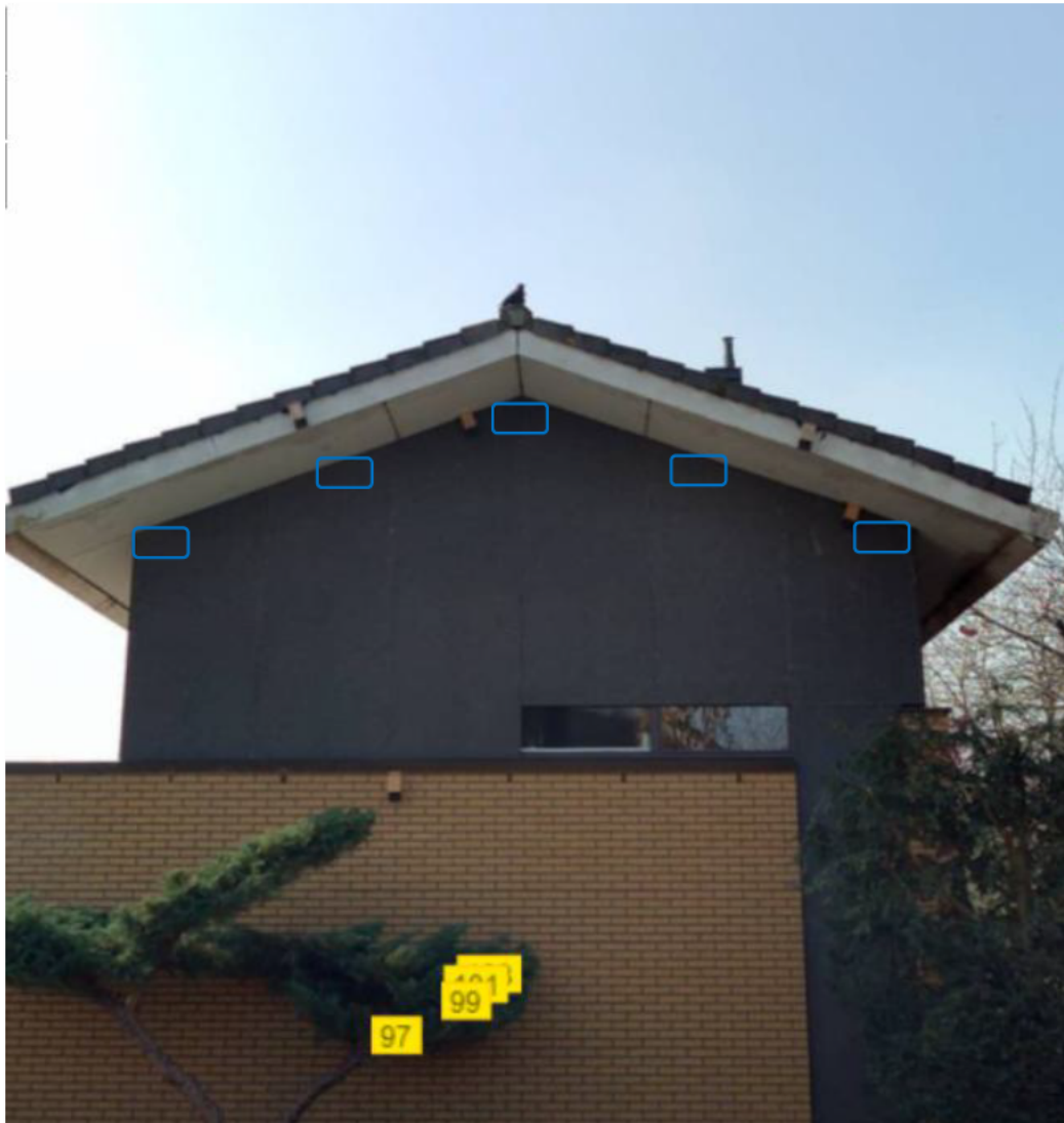
Figuur 10 Locaties van de permanente nestkasten huismus ter plaatse van de kopgevel van Eeuwenweg 97. Bron: http://streetsmart.cyclomedia.nl .
