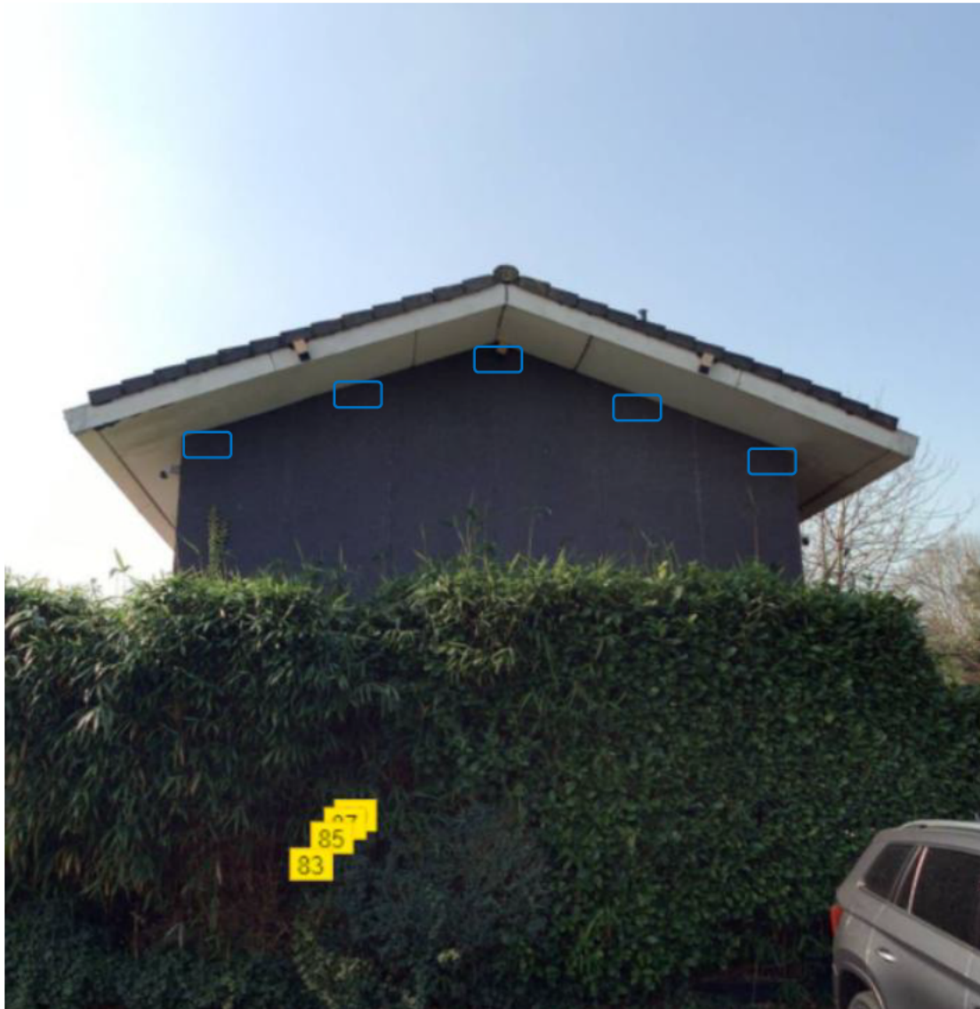
Figuur 7 Locaties van de permanente nestkasten huismus ter plaatse van de kopgevel van Eeuwenweg 83. Bron: http://streetsmart.cyclomedia.nl .
