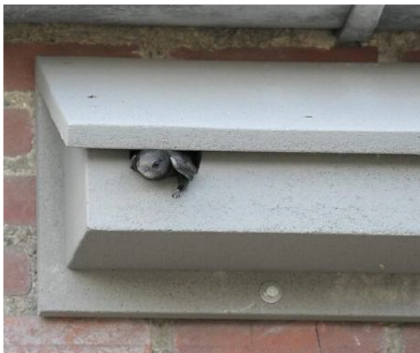
Figuur B5 Voorbeeld van een opbouwkast geschikt voor gierzwaluw, huismus en spreeuw. Bron: Vivara Pro.
