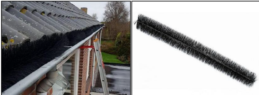
Figuur 6.6.1 Voorbeeld van vogelwerende borstels (onder dakpannen). Bron: Unitura.
