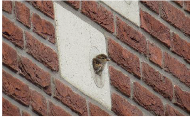
Figuur B3 Neststeen gierzwaluw type IB GZ 03 van VivaraPro (links; bron: VivaraPro, z.d.). Door huismus in gebruik zijnde neststeen rechts (Bron: Ecogroen).
