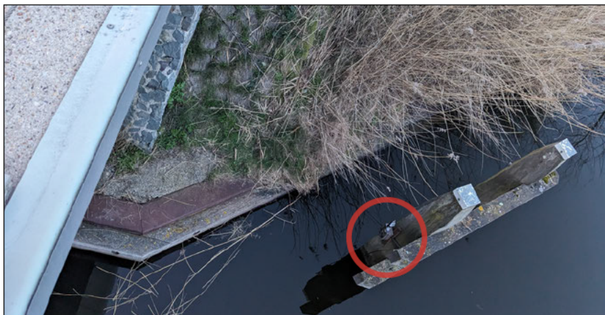
Figuur: camerapositie (in de rode cirkel) gericht op betonnen rand onder brug door.
