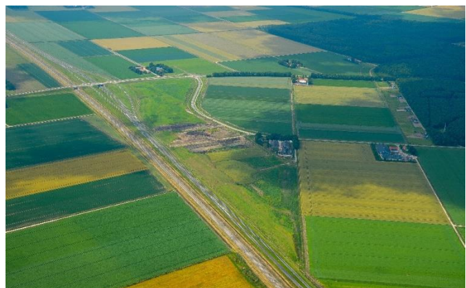
Figuur 1 Luchtfoto locatie
