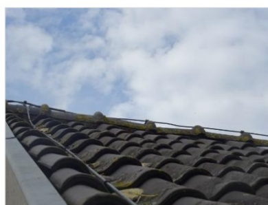
Figuur 5.7 Ruimte onder de dakpannen.
