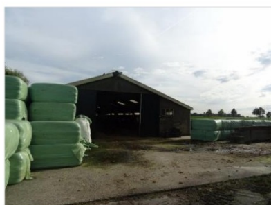
Figuur 2.9 Koeienstal gezien vanuit het westen.
