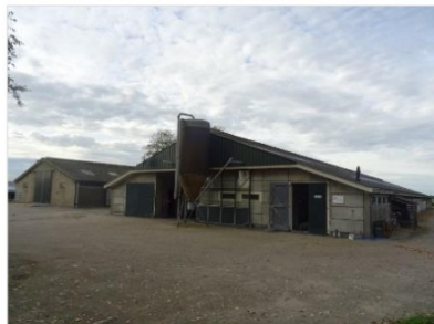
Figuur 2.6 Veeststal met schuur (links) gezien vanuit het oosten.
