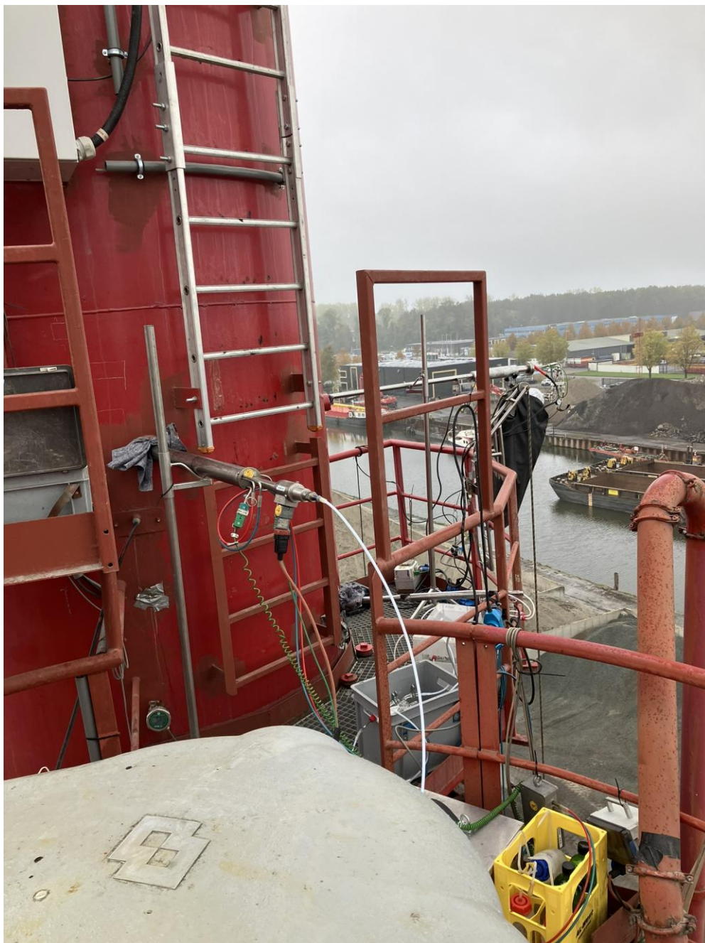
Foto 1c: Meetvlak centrale schoorsteen Gebr. Van der Lee te Lelystad, d.d. 14 oktober 2025.
