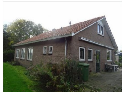
Figuur 2.5 Noordwestzijde van de te renoveren woning.
