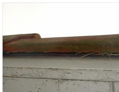
Figuur 5.3 Nestmateriaal onder de kantpannen van het woonhuis.
